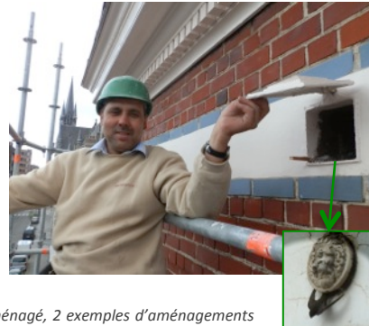
Nichoirs intégrés sous une corniche, brique intégrée, trou d'aération aménagé, 2 exemples d'aménagements de trous de boulin. (© M. Wauters, Ecosurv, Apus & Nyctalus SK, M. Ferri, M. Wauters, B. De Boeck/JC Hardy)
