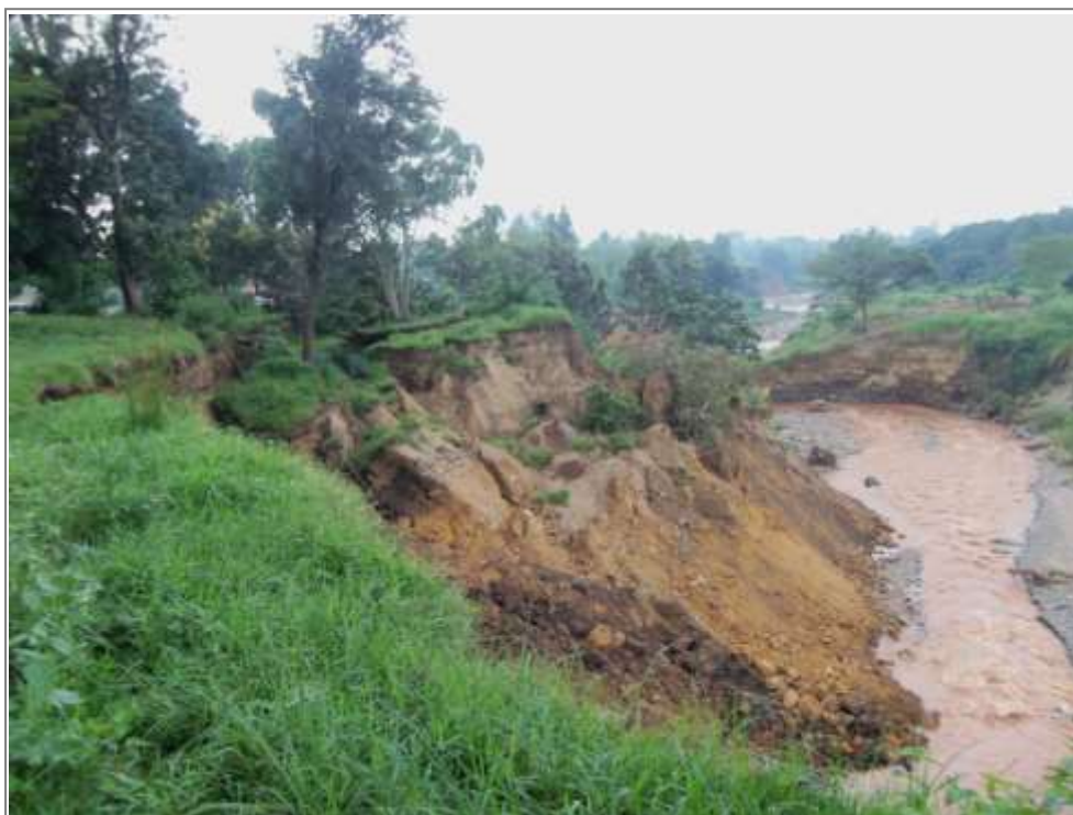
Glissement de terrain dû à l'érosion fluviale, au manque de protection des berges et au transport des produits solides dans la rivière Ntakangwa, Bujumbura, 22 février 2014
