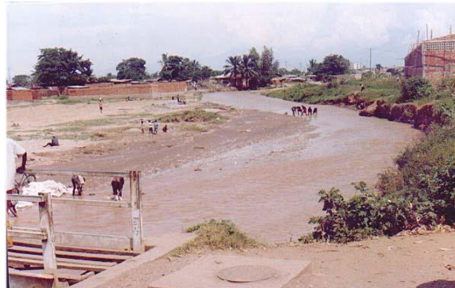
h. Menaces d'inondation sur les habitations du quartier Buyenzi dans le lit majeur de la Ntakangwa
