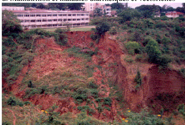
f. Menaces de destruction d'un Lycée suite aux éboulements
