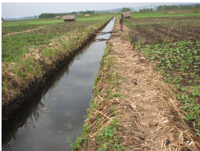
Fig. 2: Un canal tracé par la SOSUMO pour drainer les eaux du marais de Kumutongotongo
