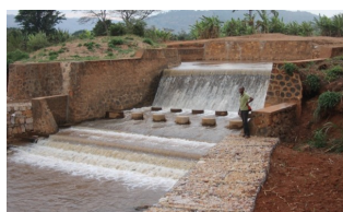
Prise d'eau dans la rivière MUSASA
