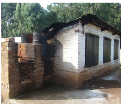
Stérilisation à la vapeur du substrat
