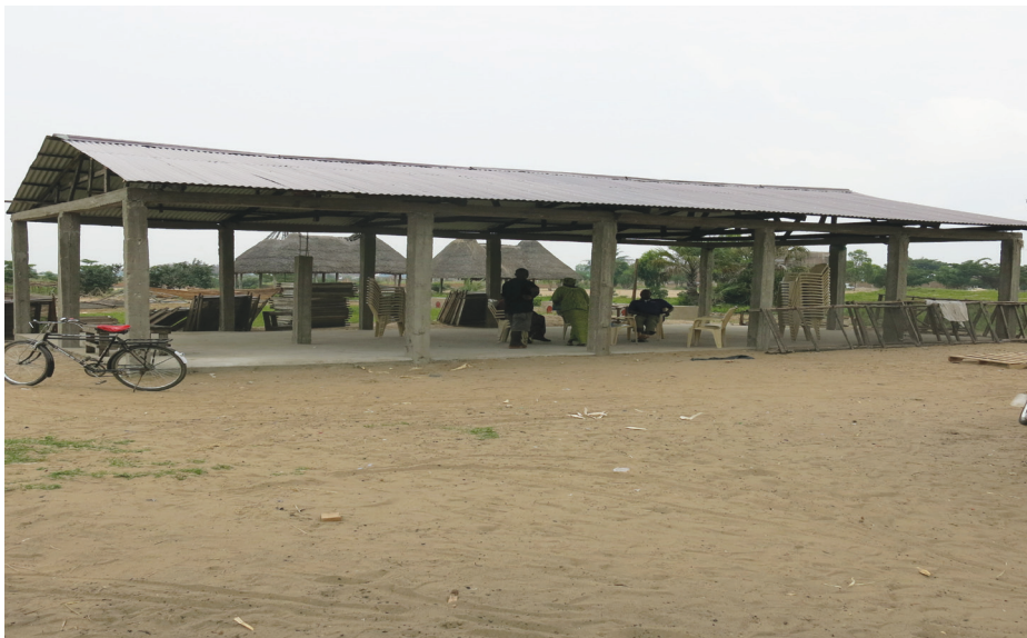
Vue de face du hangar à Kajaga
