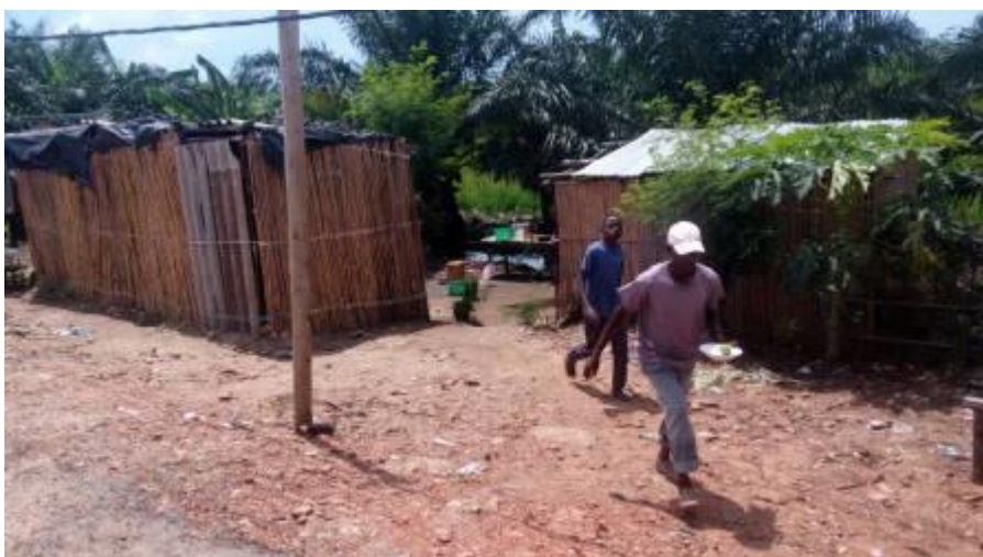
Case de restaurants de fortune au site de construction du poste frontalier de Gatumba
