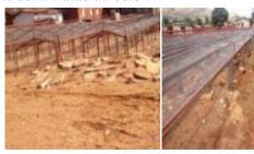
Les traverses qui constituent la charpente et sur lesquelles sont fixés les treillis sont en divers matériaux (branches de palmeraies, bambous (bambousa striata), lattes en bois divers en provenance des menuiseries, des bois de forêt et ainsi de suite.
