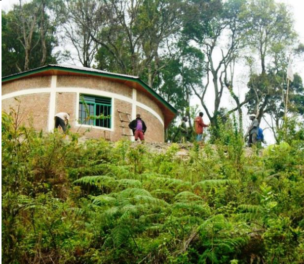
Construction du poste de garde de Kanazi (Musigati) au PNK
