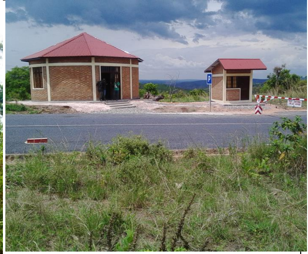
Construction du poste de garde de Gasave au PNR
