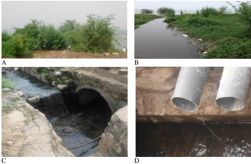
Fig. 3A-D: A,B: Eutrophisation provoquée par le flux polluant des collecteurs R 2 (à gauche) et R 3 (à droite); C,D: eaux usées et raccords de 110 mm sur le collecteur R2
