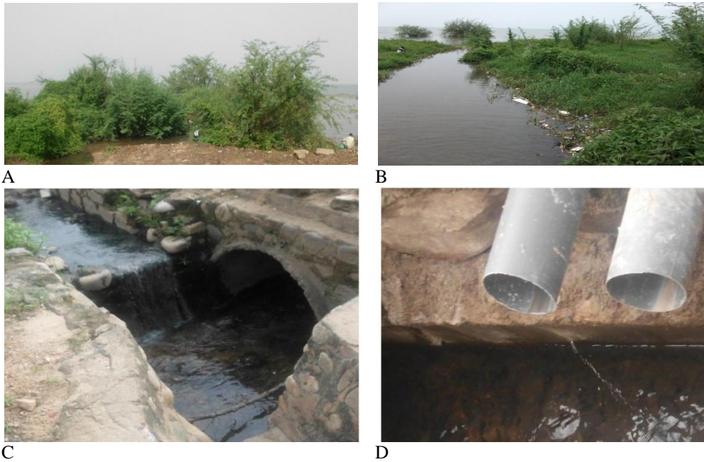
Fig. 3A-D: A,B: Eutrophisation provoquée par le flux polluant des collecteurs R 2 (à gauche) et R 3 (à droite); C,D: eaux usées et raccords de 110 mm sur le collecteur R2
